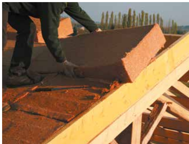
Isolation «sarking» avec une laine de bois.
