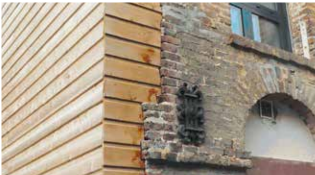
L'isolation par bardage convient à différents types de façades, même anciennes. Mais pour des raisons esthétiques, il est possible de n'isoler que certaines façades.
